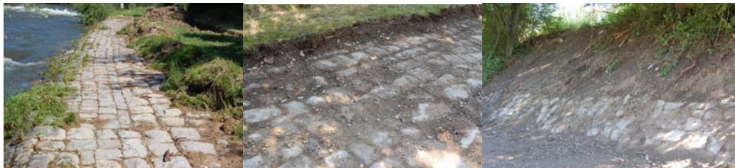
Abb.3: Dieselben Stellen während der Baumaßnahmen im Jahr 2008
