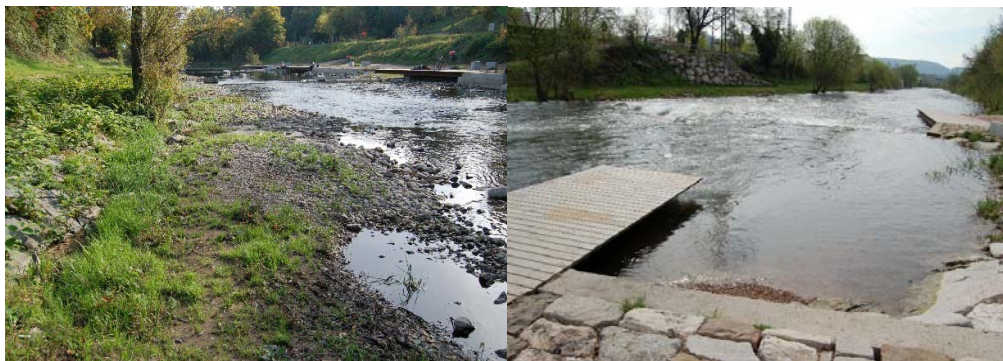
Abb.5: Zone I des linken Flussufers (Bild links) und des rechten Flussufers (Bild rechts) nach der Maßnahme
